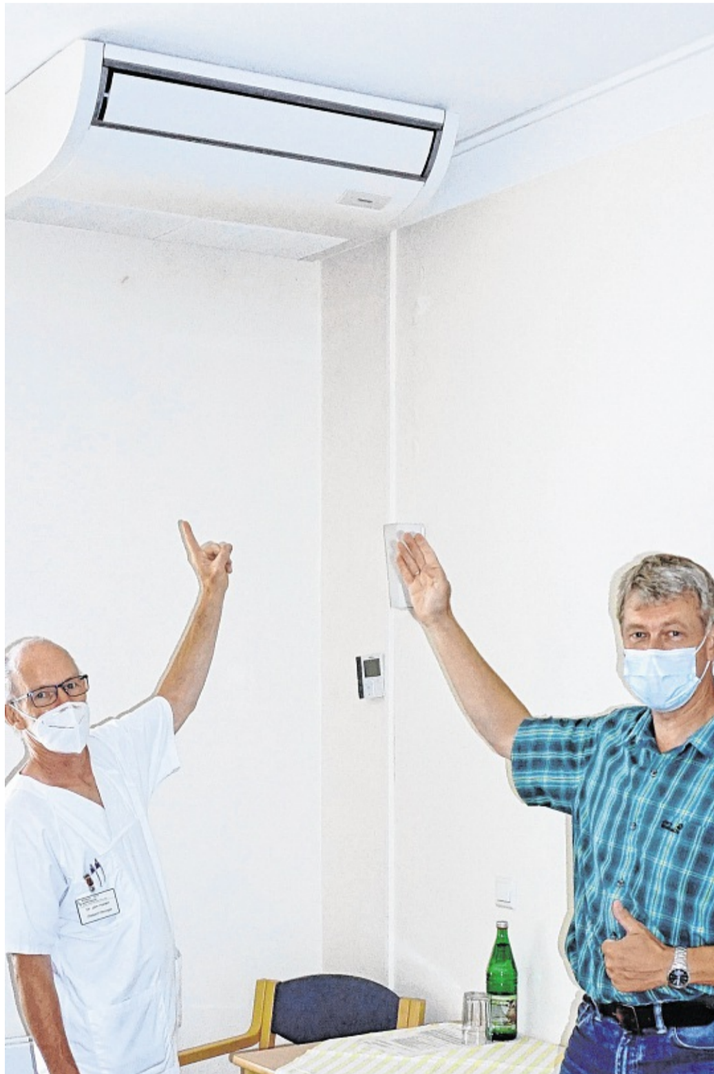
Sind stolz auf die neue Klimaanlage: Jörn Harder und Erk Roeloffs (v. li.).
